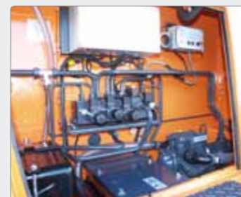
Zugänglicher Aggregate Raum für alle Steuerungselemente unter dem Motto: "geschützt und gut zugänglich"
