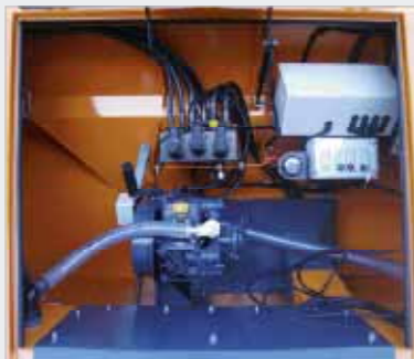
Im wartungsfreundlichen Aggregaterraum (IP 44) sind alle zentralen Komponenten leicht und überschaubar für Wartungsarbeit untergebracht. Die Klapptür schützt gegen Regen/Schnee.
